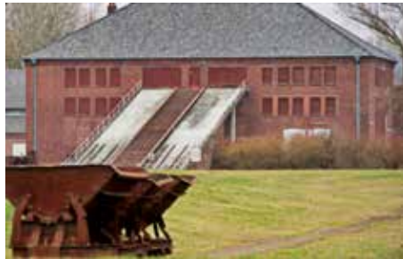
Die Rampe zum Klinkerwerk
