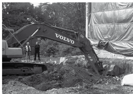
Die Kampfmittelbeseitigung bewacht die Abrissarbeiten
